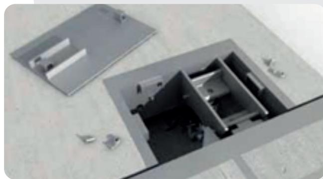
Botole di ispezione e tutte le parti metalliche costituenti il ponte sono realizzate in acciaio zincato a caldo.
